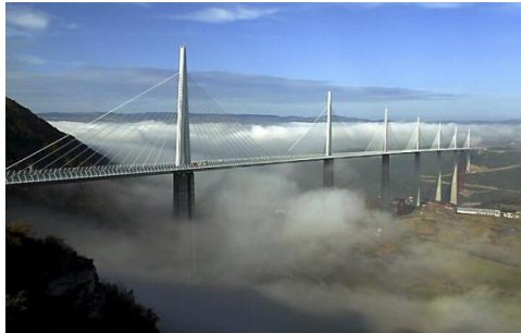
Inspection d'Ouvrages d'Art et la Photographie aérienne
